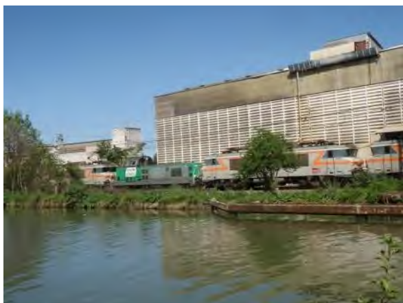
Fig. 146 : Silo à grain, Lespinasse
