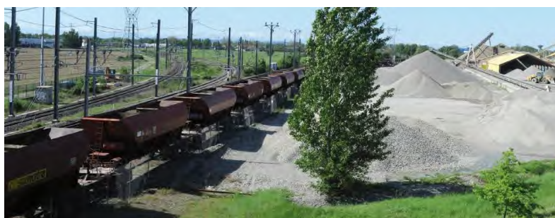
Fig. 196 : Plateforme de déchargement et de stockage de granulat
