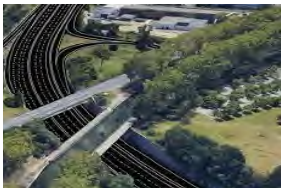
Fig. 45 : Pont-canal des Herbettes (©DDT 31)
